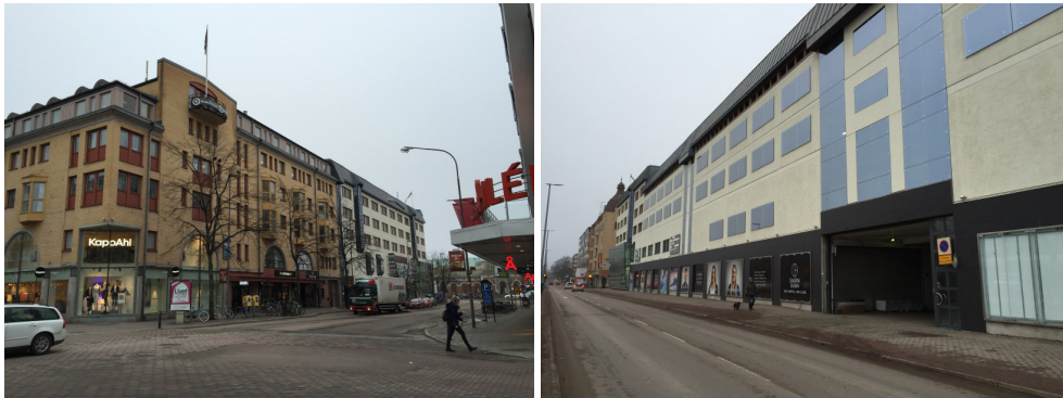
Bild 1 Planområdet sett från Åhléns, i nordväst. Bild 2 Befintlig byggnad sett från Hamngatan, i söder.
