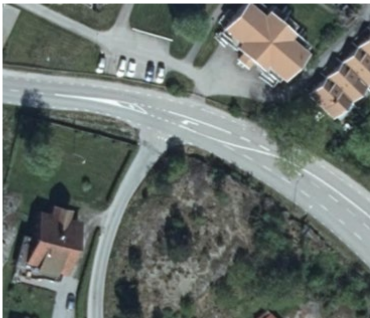
Vänstersvängfält vid avfarten från Färjevägen till Skogslyckevägen.
