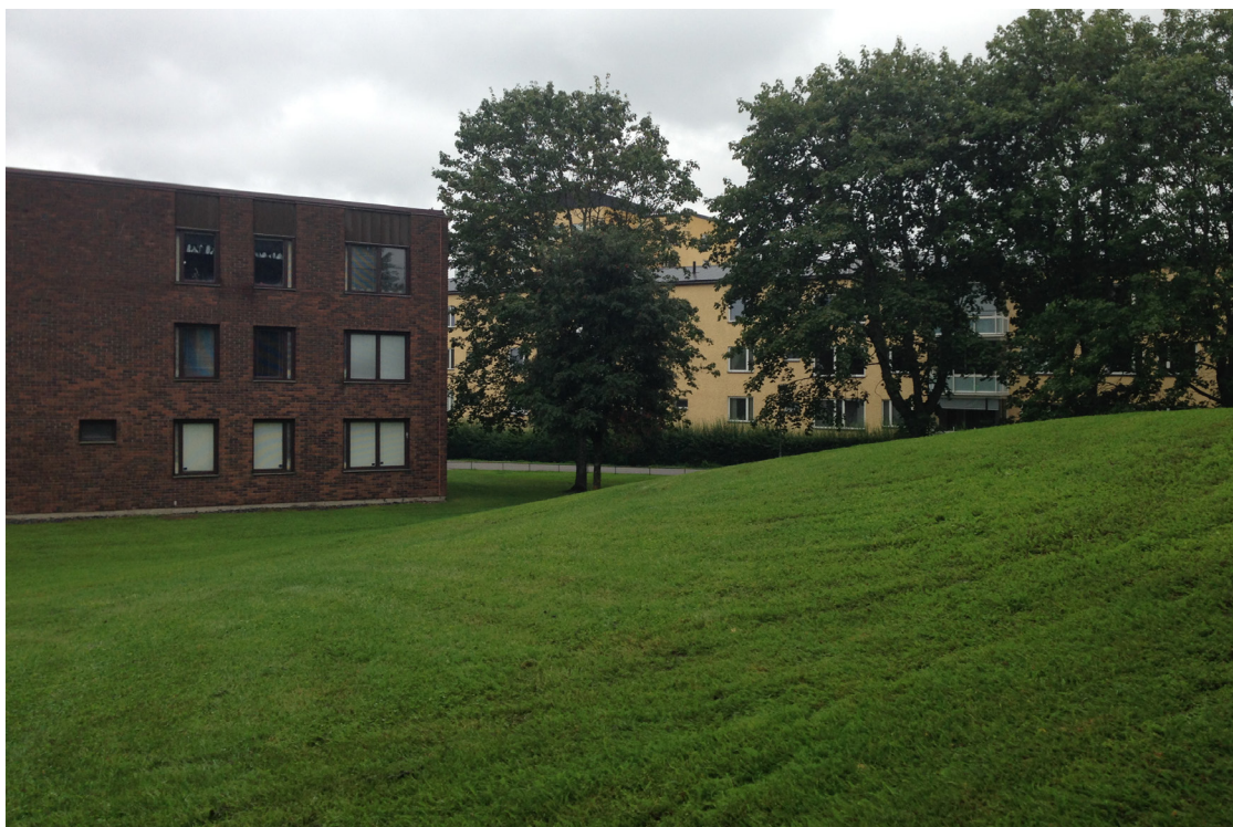
Vy från nya byggnadens södra fasad.
