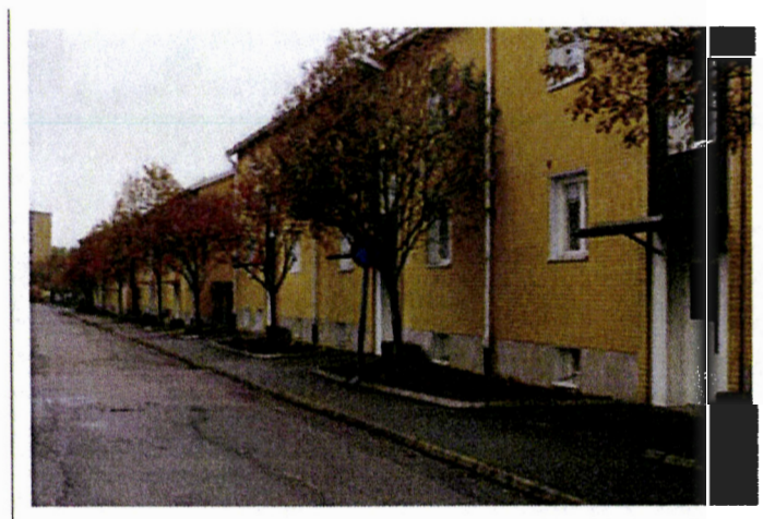
Bostadshusen vid Barnängsgatan.
