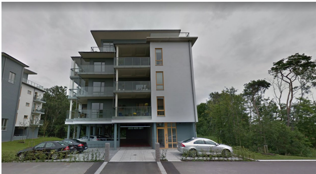
Parkeringsplatser i markplan under bostadshus skapar möjlighet till parkering utan att ta grönytor i anspråk (bild från Lomma, Google maps)
