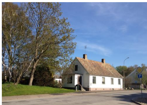
Bild: Bostadshuset sett från nordväst.
