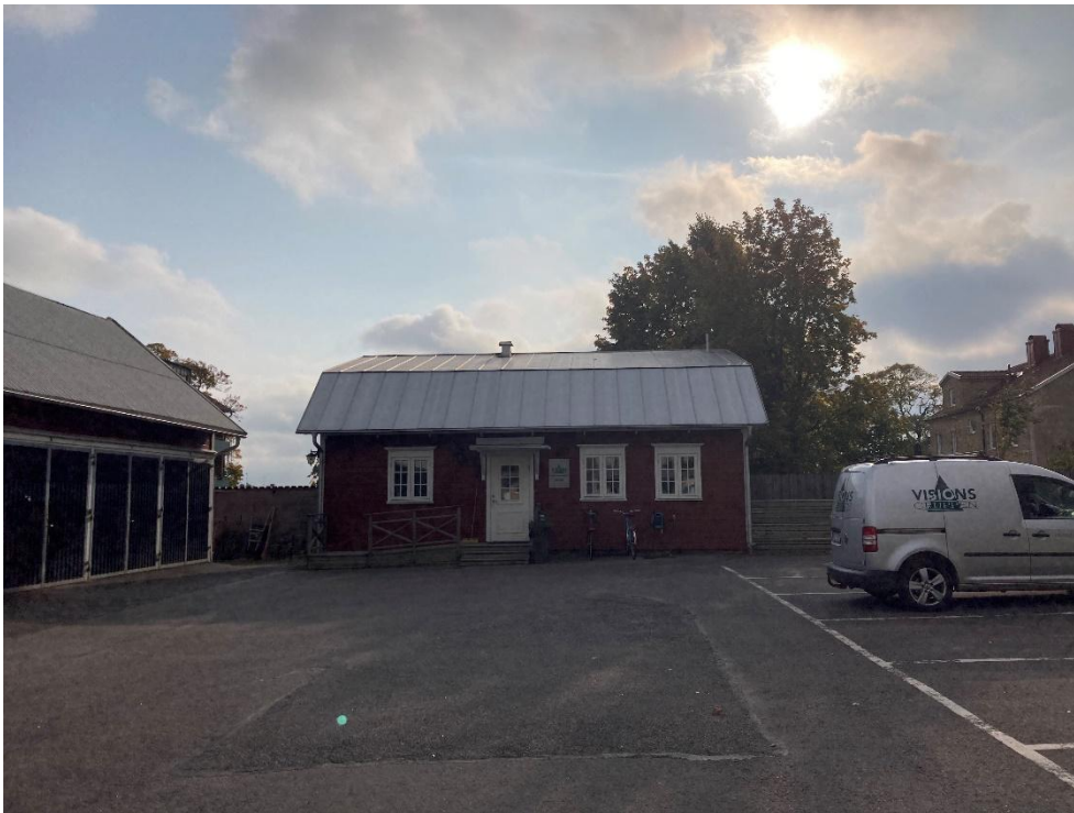
Figur 11 visar kontorsbyggnaden (nr 3 i figur 8) inom fastigheten Ejdern 17.
