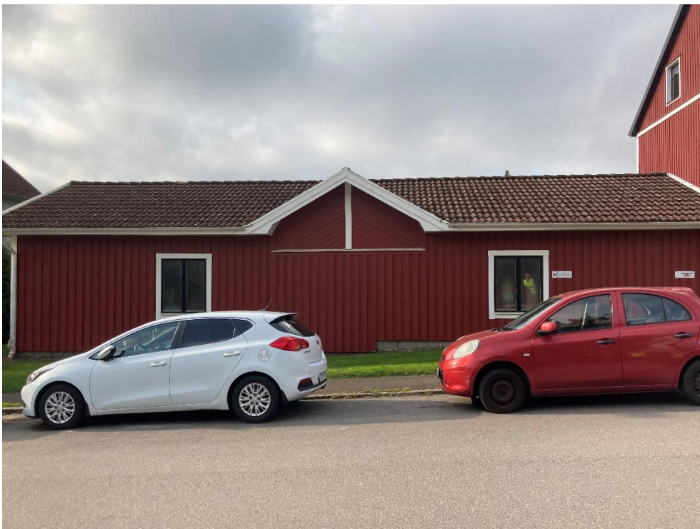
Figur 14 komplementbyggnaden inom fastigheten Ejdern 21.
