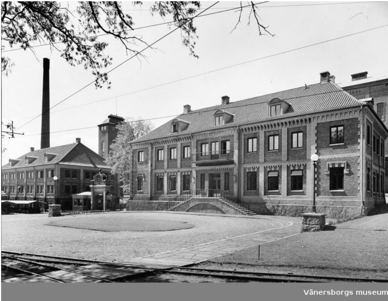
Entrén till bruksområdet på 1940-talet, efter förlängningen av kontorsbyggnaden mot norr samt anordnade av huvudentré mot öster med en fritrappa. Vänersborgs museums arkiv.
