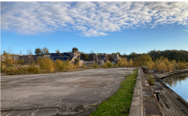
Platstyp 1, västra delen av kajområdet.
