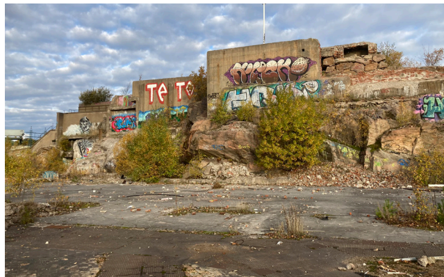
Platstyp 2, monumentala betongfundament i södra delen av bruksområdet.
