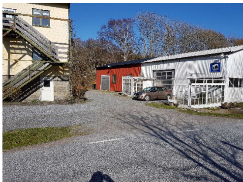
Förrådsbyggnad på Hee 1:60
