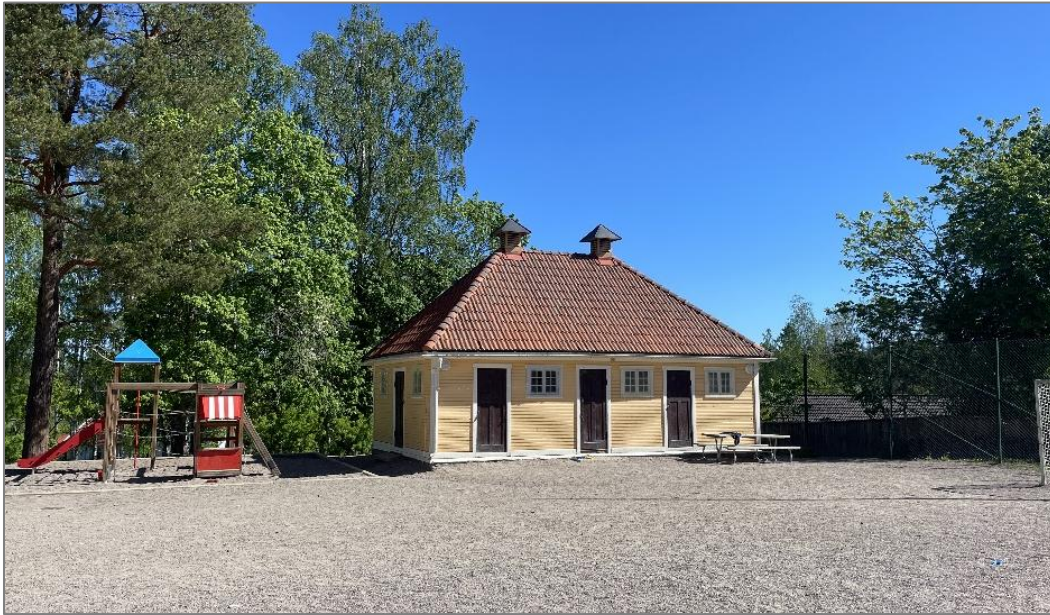
Figur 18. Uthusbyggnaden sett från norr.
