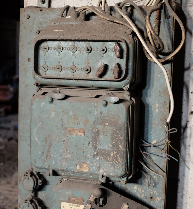
Bild 59. Detalj inifrån Martinverket.
