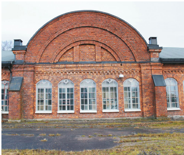
Bild 35. Del av filfabrikens fasad mot järnvägen. (Melica, 2018)
