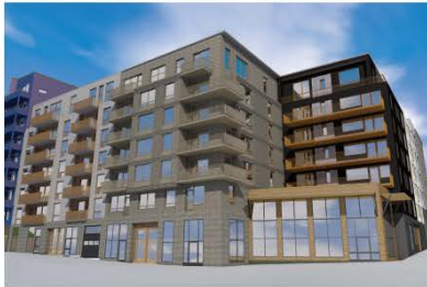
Vy från tunnelbanastations entré
