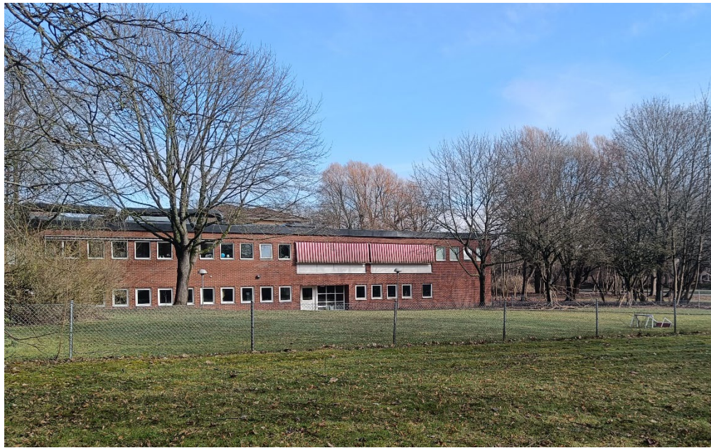
Förskolebyggnaden sedd från söder
