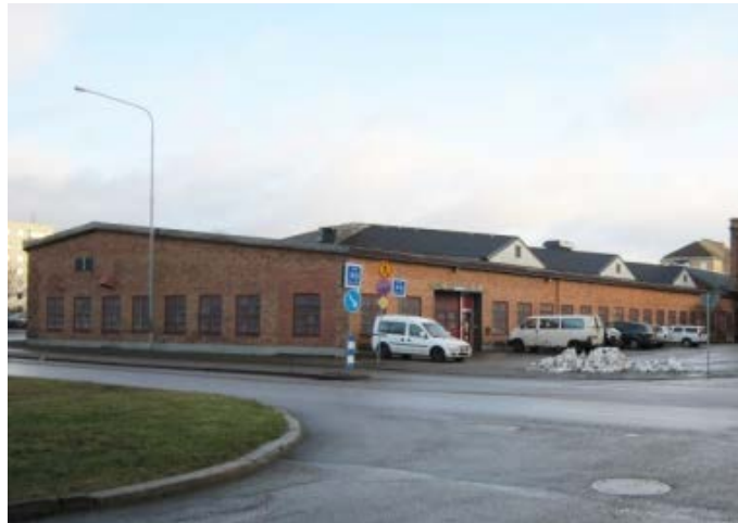
Fd industribyggnaden längsida mot Köpmangatan
