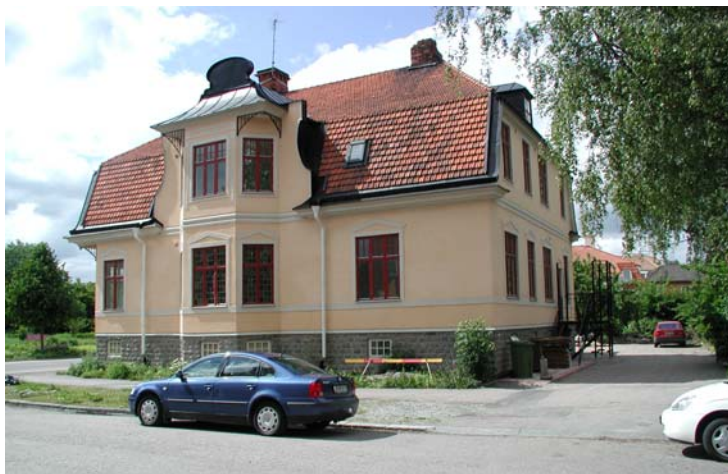
Renoverad byggnad på fastigheten Centrum 4:3.
