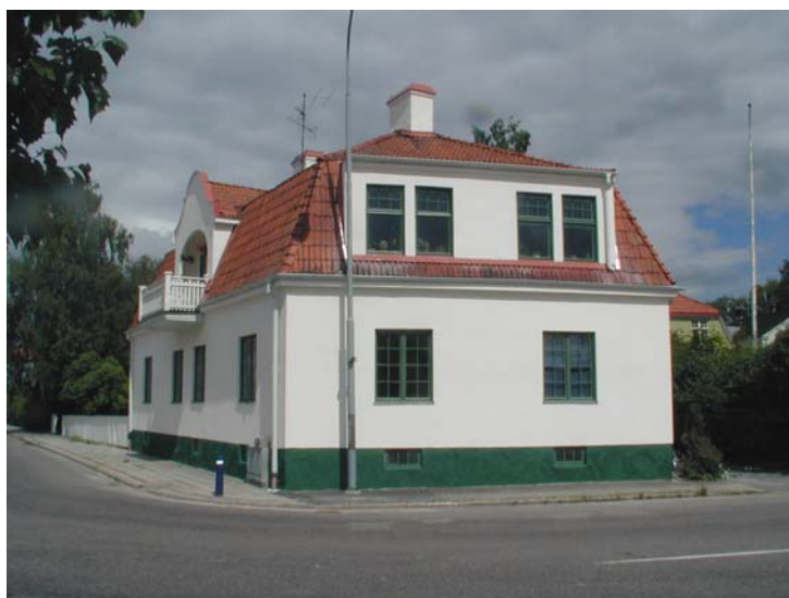
Renoverad byggnad på fastigheten Centrum 4:4.
