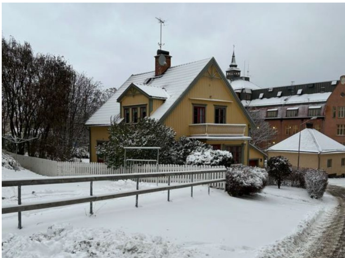
Bild 23: Villan sedd från Läroverksgatan. I bakgrunden syns vaktmästarbostaden och läroverket (Norconsult, 2023)
