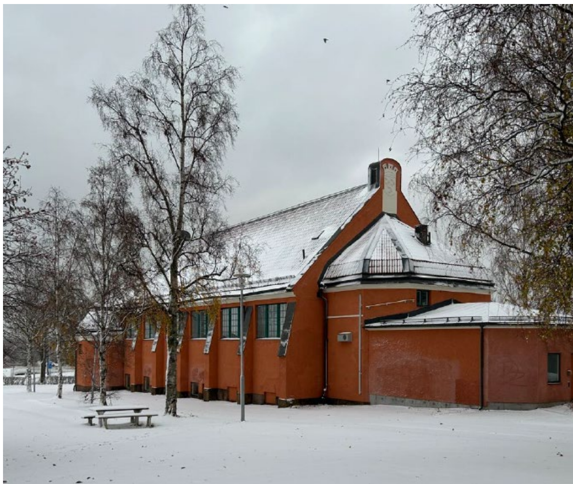
Bild 17: Bilden visar idrottsballens långsida med stränpelarna, de stora spröjsade fönstren symmetriskt placerade emellan samt det branta tegelklädda taket med ett karaktäristiskt gavelmotiv som avslutas med en relief (Norconsult, 2023)
