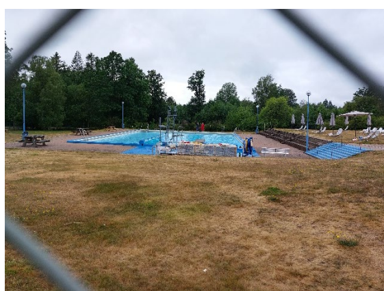
Befintlig utomhussimbassäng inom campingområdet
