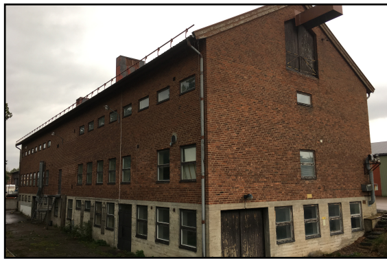
Byggnad 116. Vy från sydväst.
