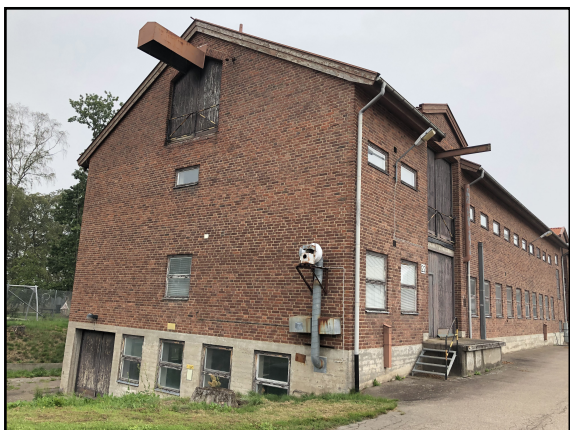
Byggnad 116. Vy från sydost.
