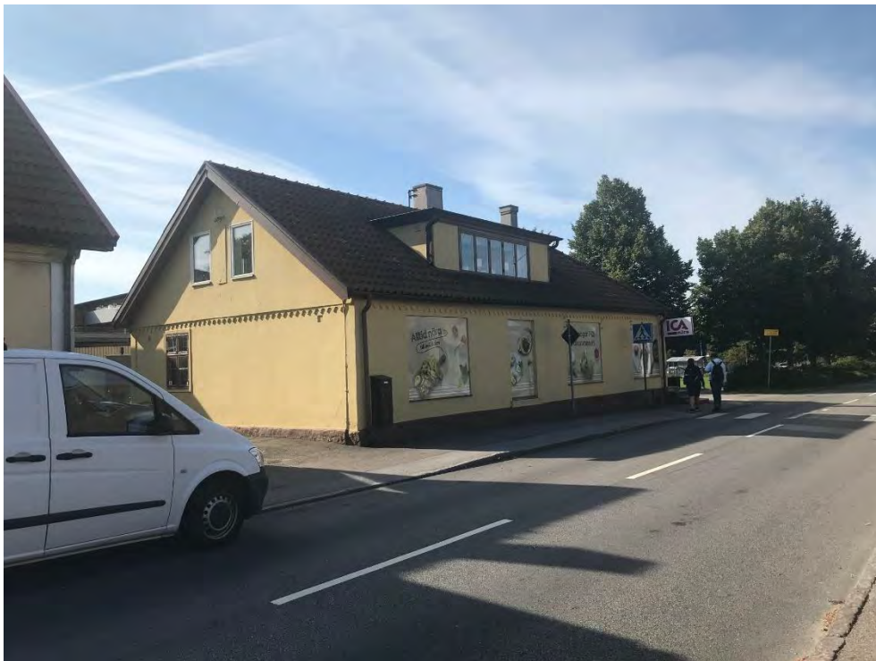
Figur 8 ICA-butiken är en av de äldsta byggnaderna i Löberöd.
