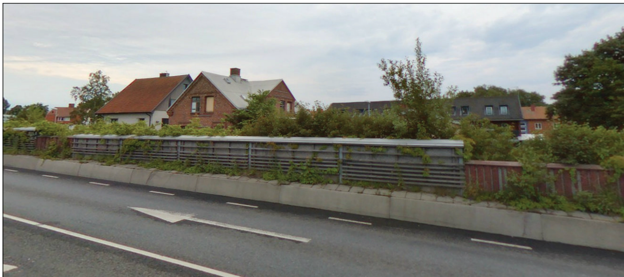
Betongbarriär som även fungerar som stödmur. Bullerskärmen är grundlagd bakom barriärelementet.
