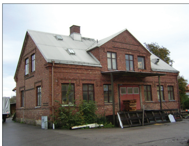
Brudtärnan 4, foto från byggnadsinventering (2006).
