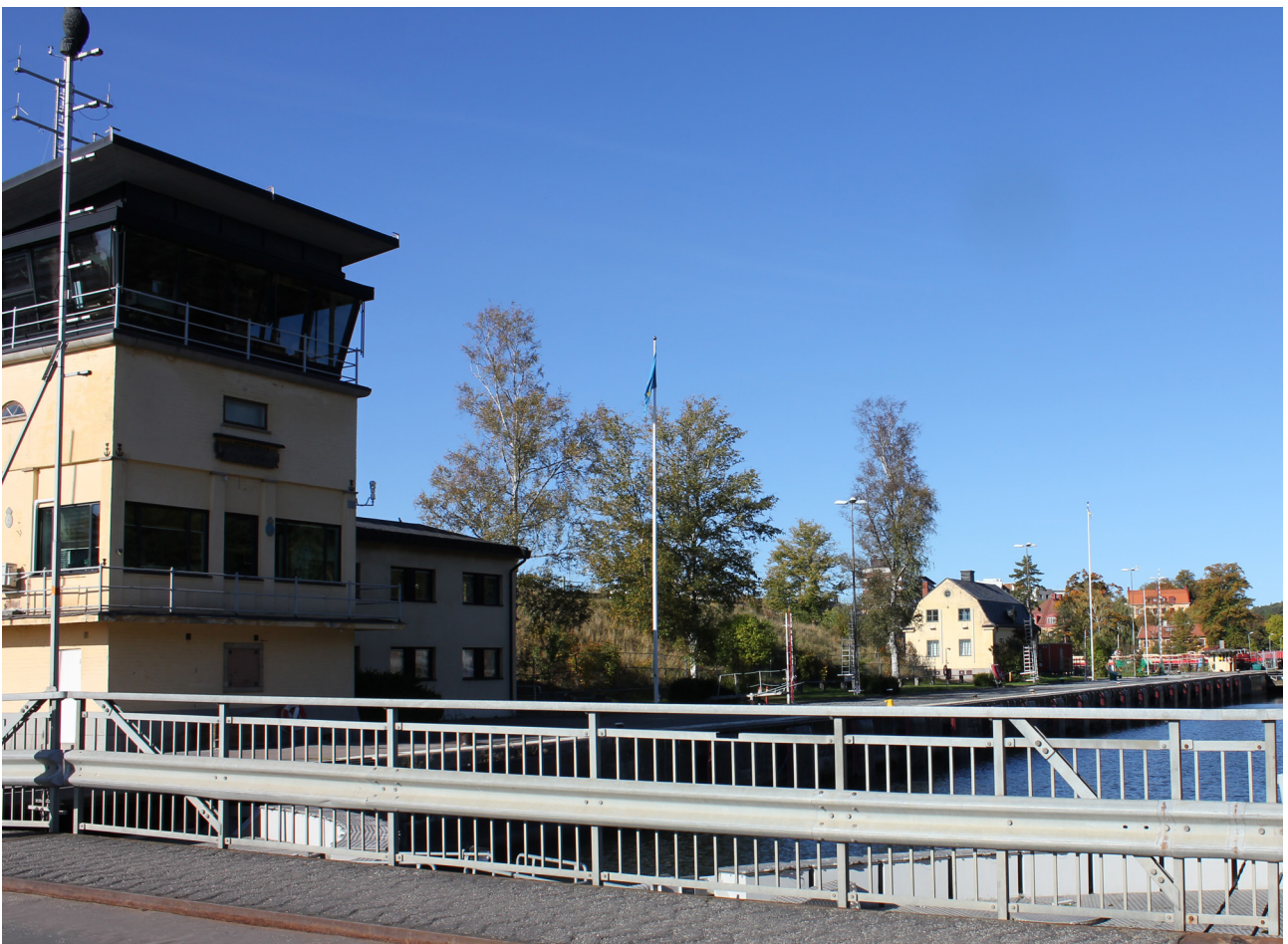
Bilden visar Manövertornet. I bakgrunden syns kanalmästarbostaden.
