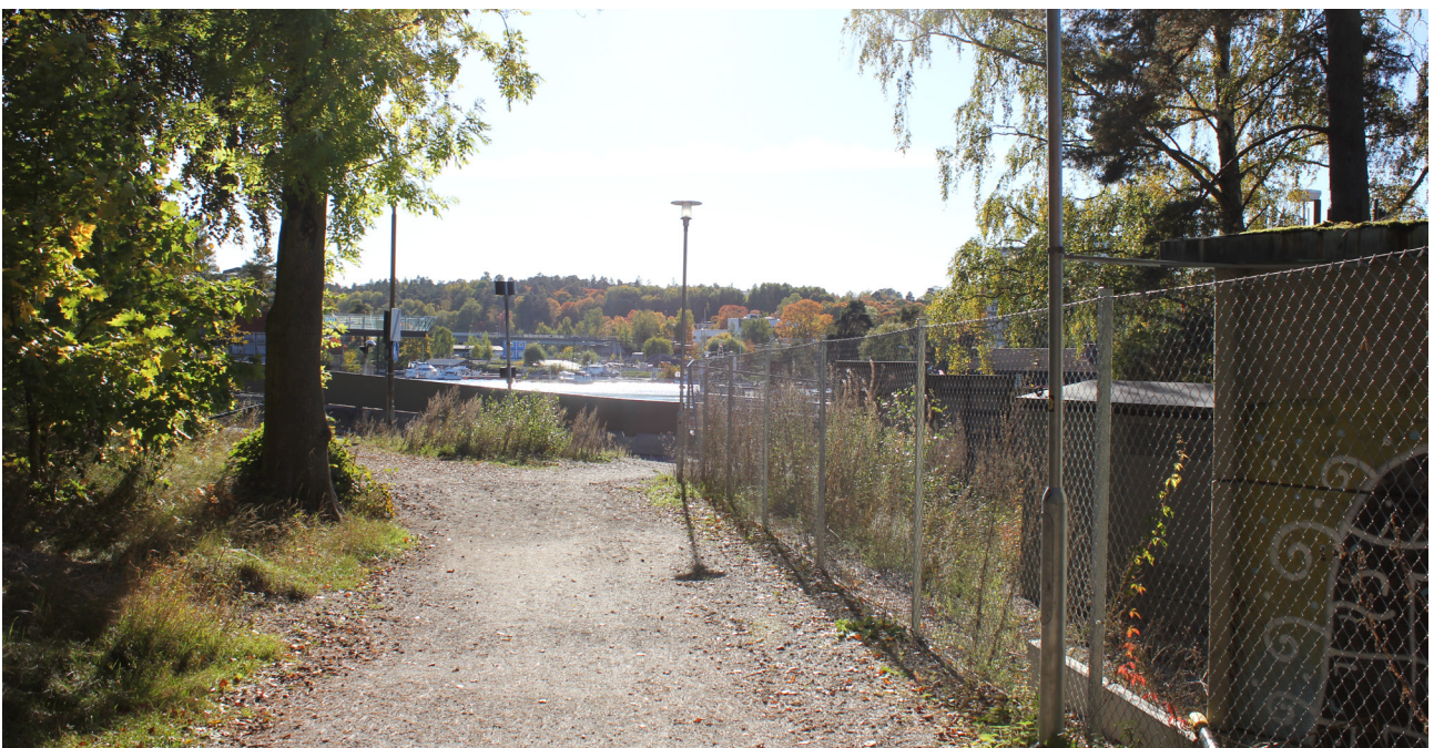
Fotot visar befintligt kanalstråk vid foten av Kusens backe. Vy mot syd.
