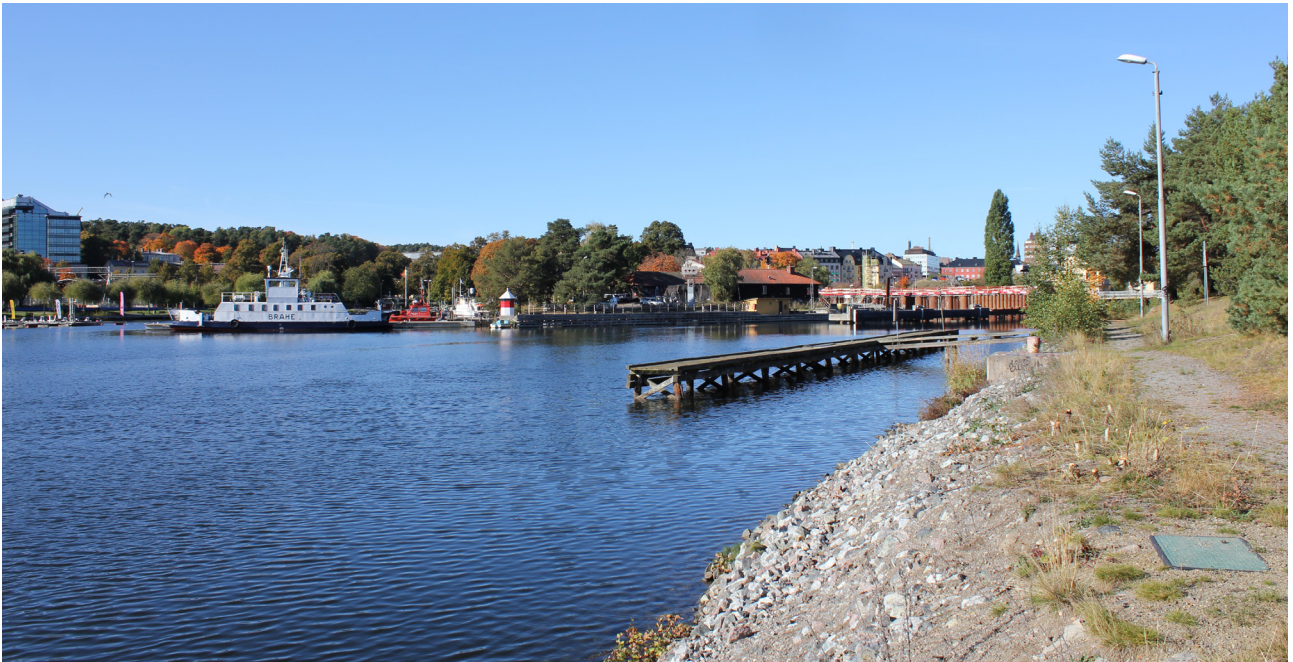
Fotot visar befintligt kanalstråk (grusvägen till höger i bild) söder om den befintliga slussbron.
