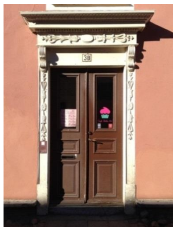
Detaljbild på en av portarna med pardörr.
