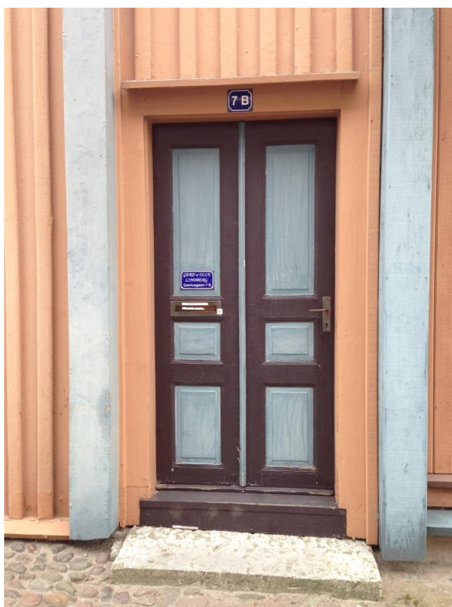
Detaljbild pardörr och knutlådor.
