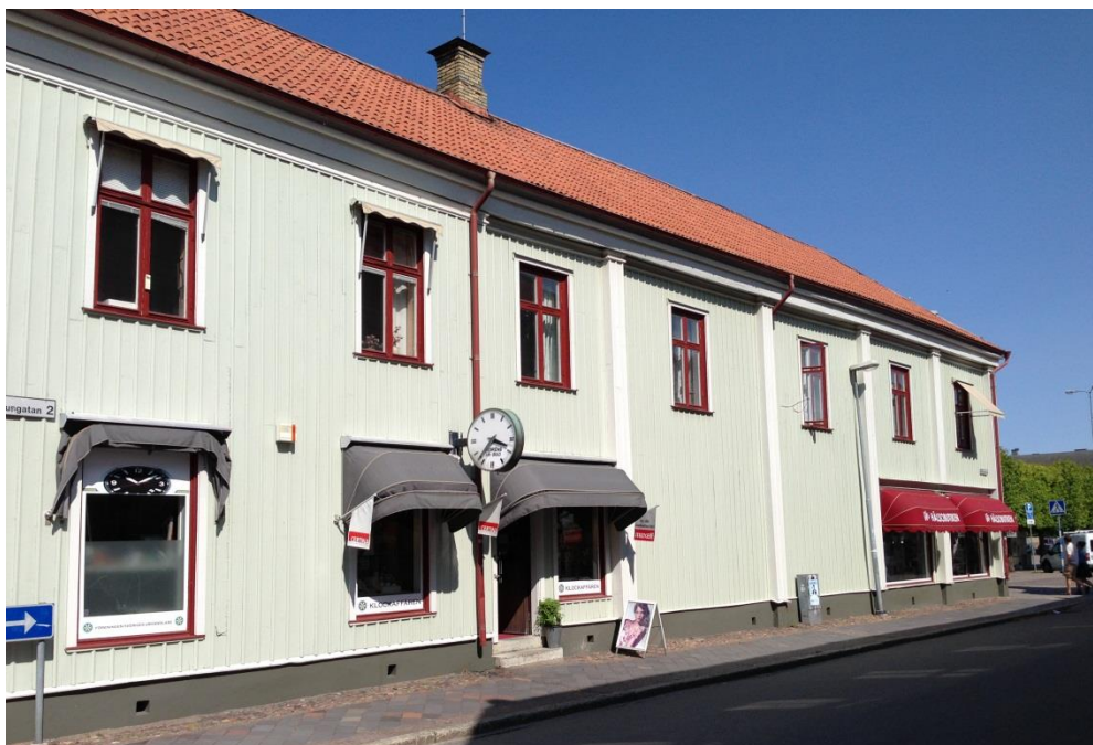
En byggnad med typisk karaktär för stadskärnans bebyggelse. Byggnaden har rött sadeltak och två våningar med handel i bottenvåningen och bostäder över.
