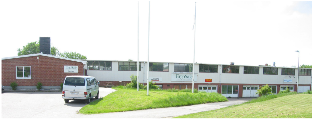
Byggnad på fastigheten Trönninge 3:31
