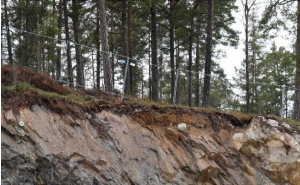
Bergskärning, brant stupande sprickplan på grannfastighet Ösby 1:79. Vy mot nordväst.
