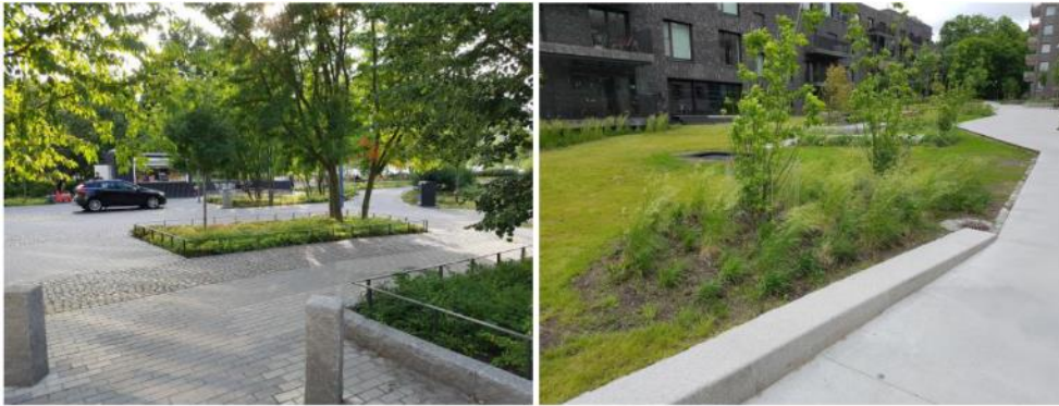
Exempel på växtbäddar för dagvattenhantering
