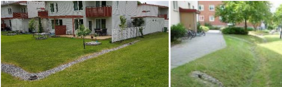
Makadamdike respektive öppet dike för dagvattenhantering.
