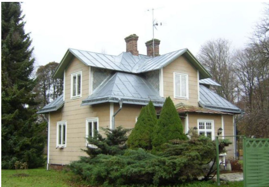
Bild från byggnadsminnesutredning, chefsbostaden.
