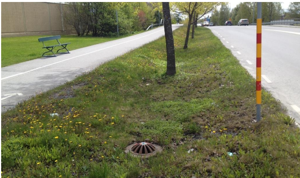
Figur 12: Exempel på svackdike i Östersund. Svackdiket avslutas i en kupolbrunn, som kan upphöjas för att skapa ytterligare fördröjningsvolym. Foto: Rickard Olofsson, Sweco.
