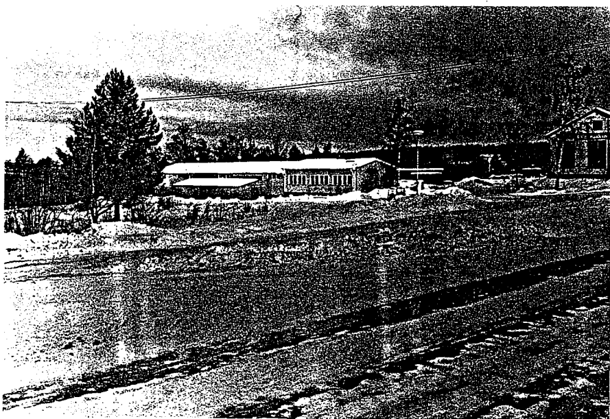
Förrådsbyggnad (Hyresgäst: Marklunds Elektriska)
