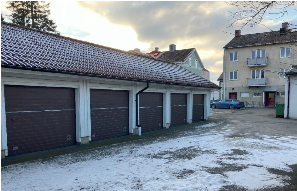
Bild 6 visar befintlig garagebyggnad på fastighetens östra sida.
