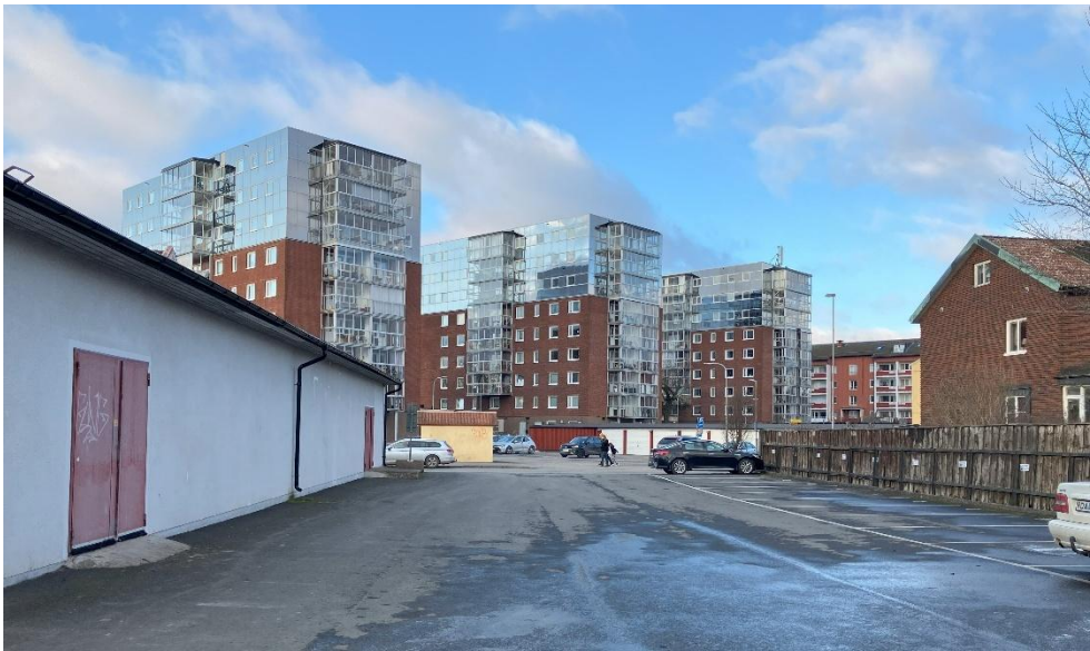
Bild 24 visar upplevelsen av de höga flerbostadshusen norr om planområdet. Bilden är tagen från parkeringsytan inom planområdet.
