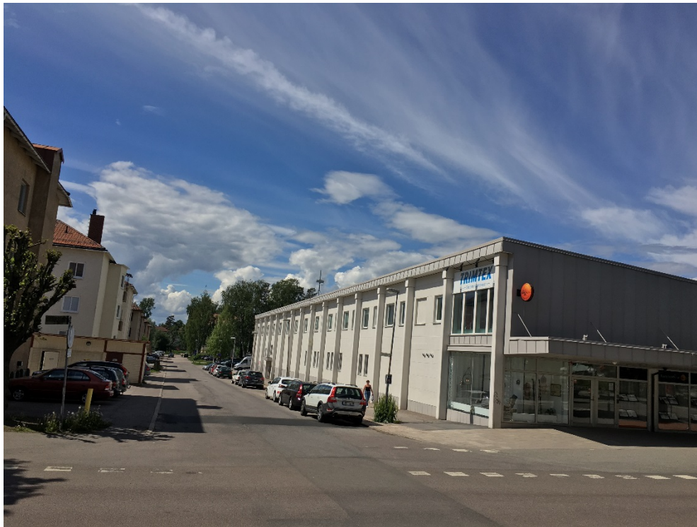
Befintlig byggnad inom planområdet till höger i bild.
