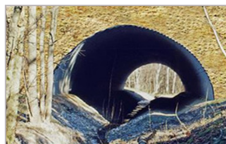
En större oval trumma, s.k. rörbro, föreslås anläggas under ny väg tvärs bäckravinen.
