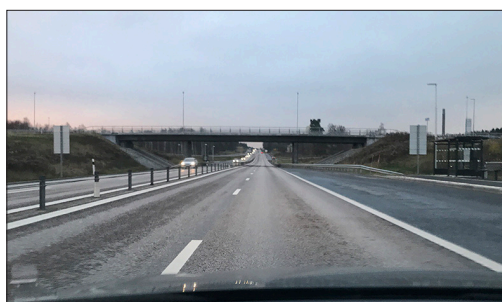
Trafikplatsen i riktning söderut mot Skövde.
