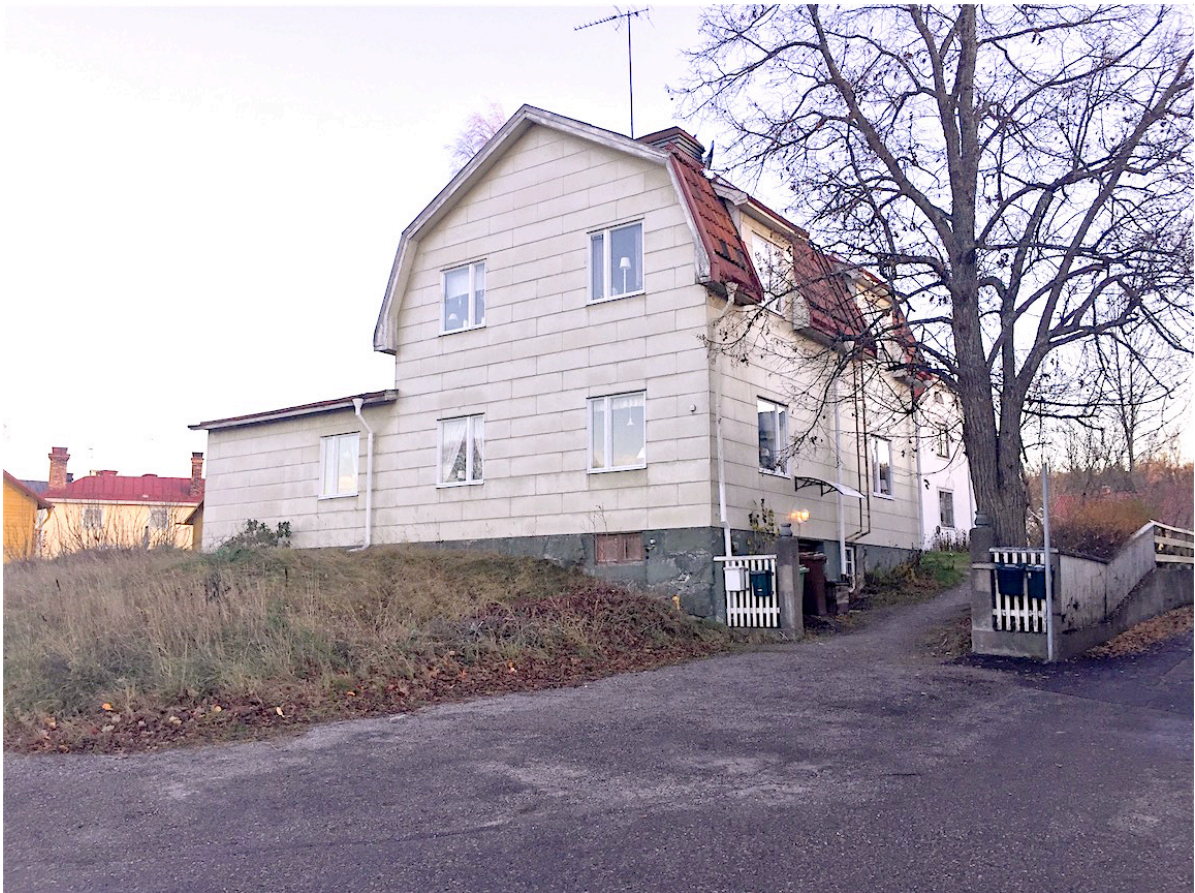
Simpan 3 från Södra Järnvägsgatan
