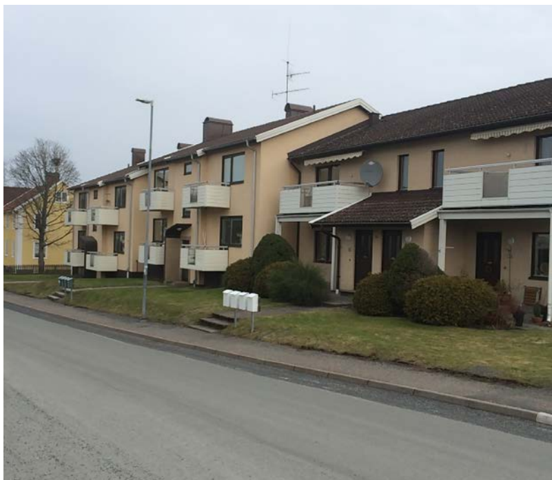
Bild på befintlig bebyggelse sett från Tidaholmsvägen.
