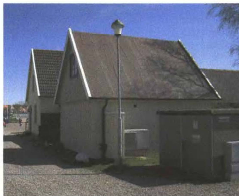
Komplementbyggnad inom planområdet från väster
