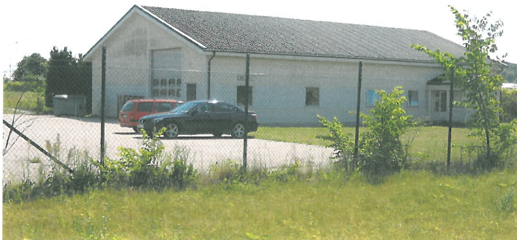
Befintlig verksamhetsbyggnad på fastigheten Gurkan 4.
