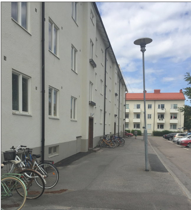
Befintligt bostadshus med förgårdsmark, Kv. Lodjuret.
