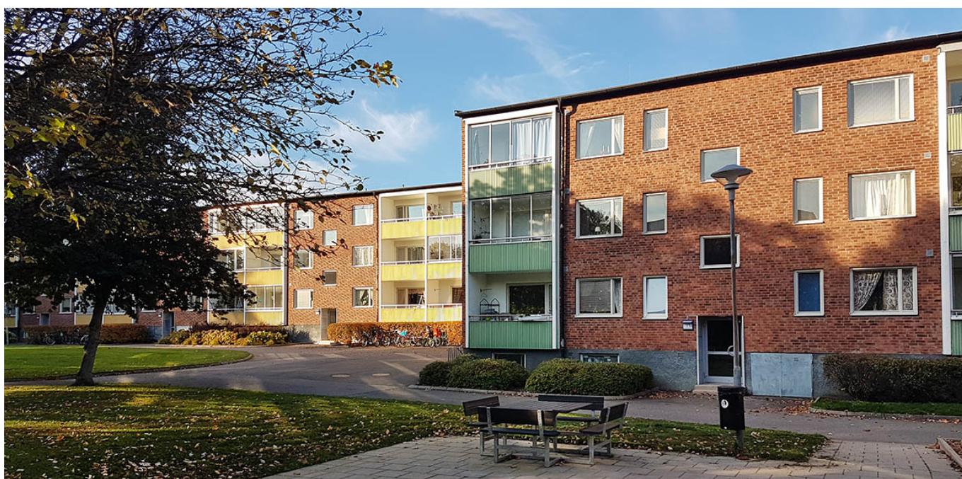
En av bostadsbyggnaderna på Storegården med sina generösa grönytor och balkongfronter i grönt och gult.
