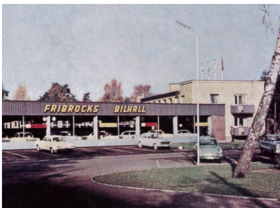
Fribrocks Bilhall mot Arbingatan, uppförd 1965.
