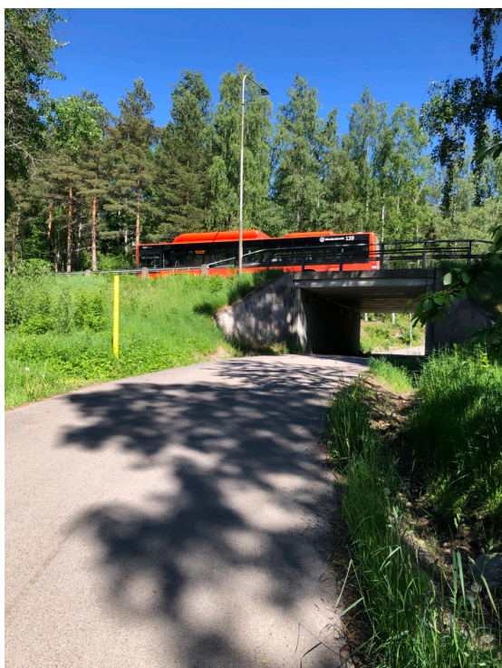
Befintlig gc-port under Vårgatan.
