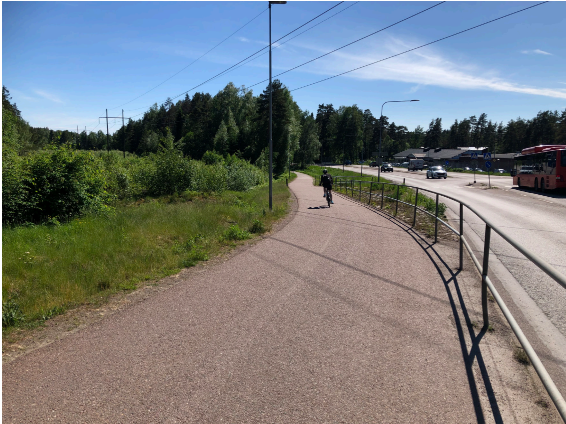
Befintlig korsning mellan Sommargatan och Edsgatevägen samt befintlig kraftledning som korsar området.
