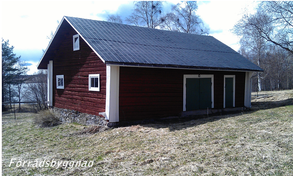
Förrådsbyggnaden är uppförd i timmer med synliga takåsar och knutarna skyddade av vitmålade knutlådor. Före detta vedbod och iskällare.
