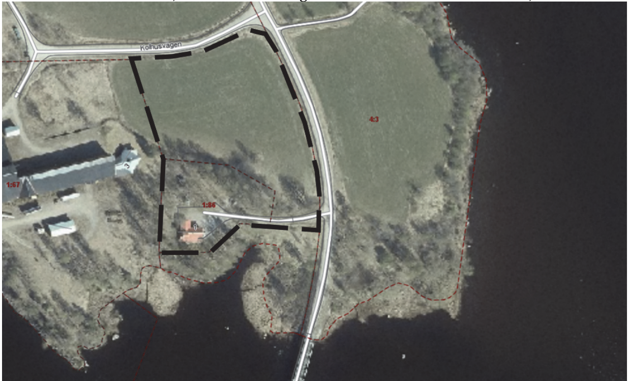
Åkermark i norra delen och mer vegetation runt det befintliga avloppsreningsverket i den södra delen
