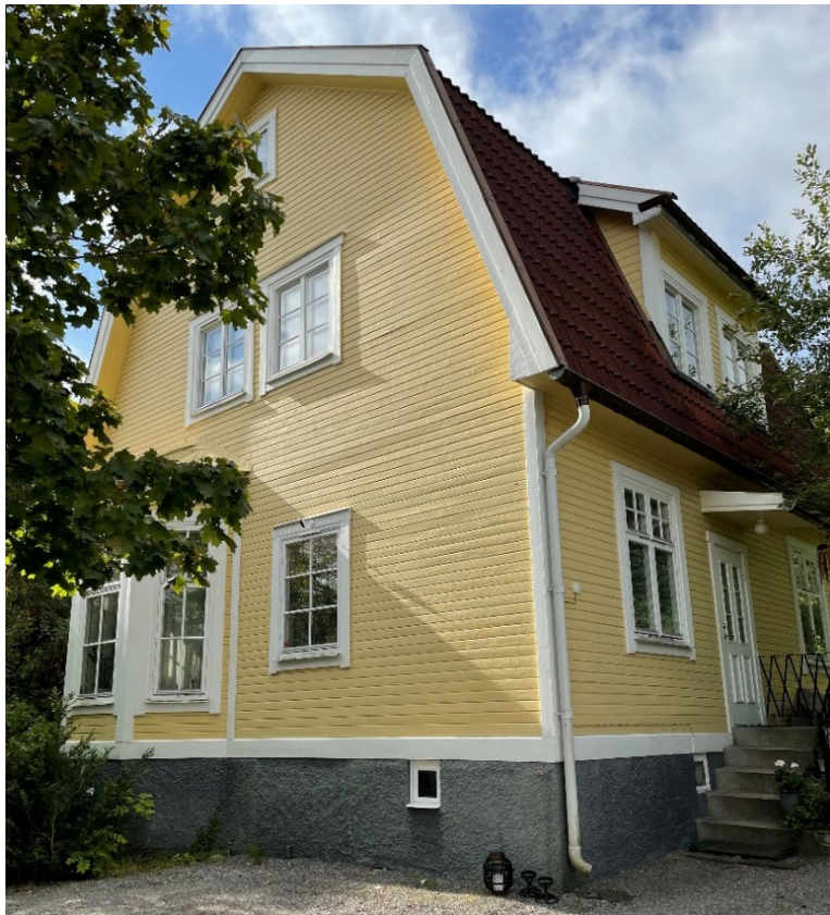
Bilden visar huvudbyggnaden på fastigheten Lidingö 10:573 sett från norr.
