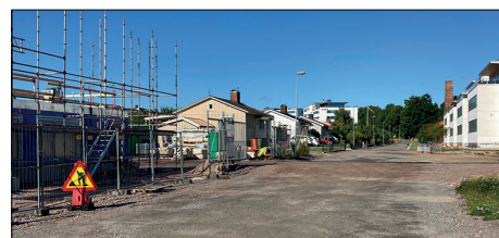
Mariesjövägen västerut med villabebyggelsen till vänster, kontorshus för SPS till höger samt Skövdebostädernas pågående byggnation närmast till vänster.
