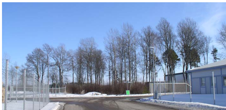
Trädbevuxet område (område 1) sett från Granitgatan i väster. Byggnad Kronans Droghandel skymtar bakom träden.
