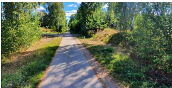
Befintlig gång- och cykelväg i anslutning till området. Banvallen. Bild: Trafikutredningen.
