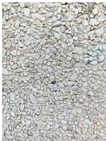
Figur 14. Befintligt betongelement med synlig ballast.
