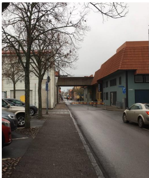
Figur 27. Bron över Norra Torngatan åt norr.
