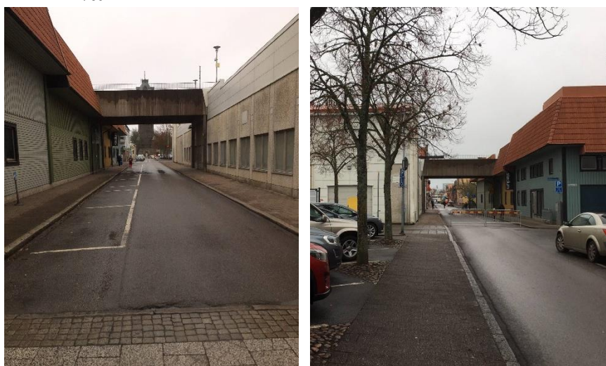
Figur 18. Bron mellan Pollux och Pomona. T.v. vy mot gamla vattentornet. T.h. vy mot Rörstrands "R:et".
