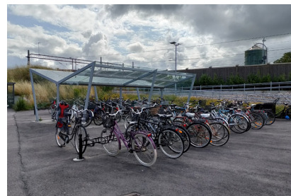
Välanvänd cykelparkering vid Båstads stations norra entré.
