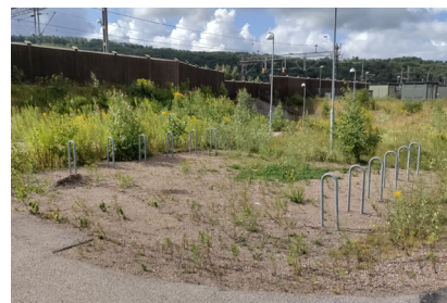
Cykelparkering vid Båstads stations södra entré. Bristande standard, underhåll och vägvisning avskräcker cyklister från att använda parkeringar som denna.
