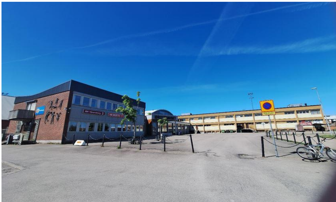
Idrottshuset med tillhörande utbyggnader. Källa: Vänersborgs kommun
