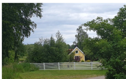
Befintlig byggnad invid golfbanan på fastigheten Färlöv 19:8. Foto: Kristianstads kommun
