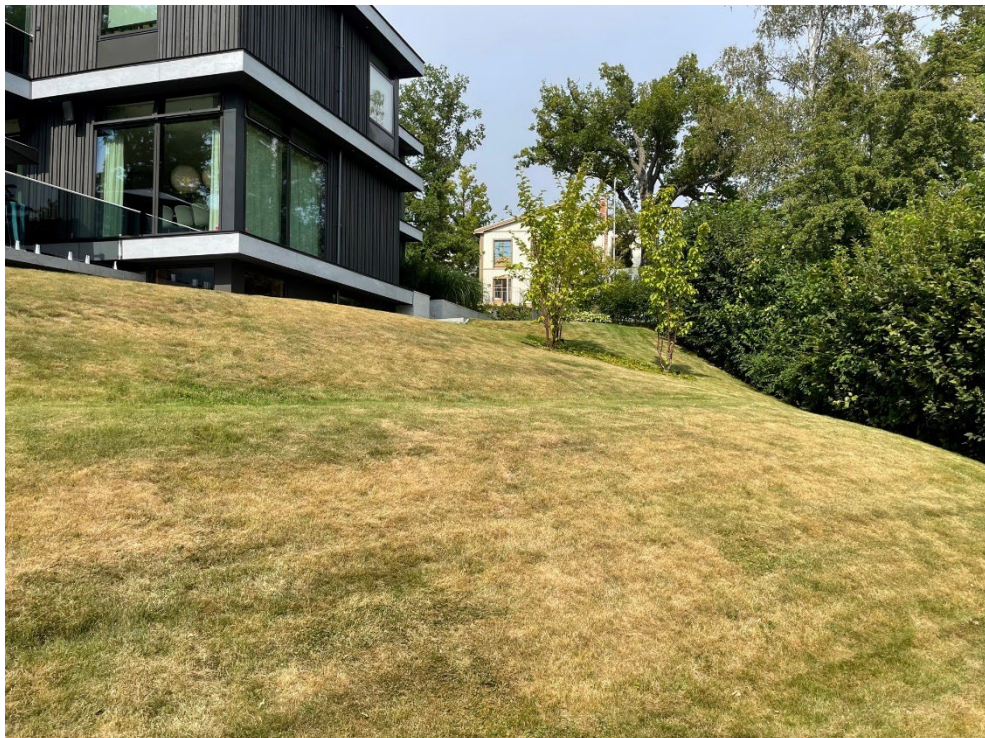
Vy över befintlig huvudbyggnad och terräng på fastigheten Havren 9
