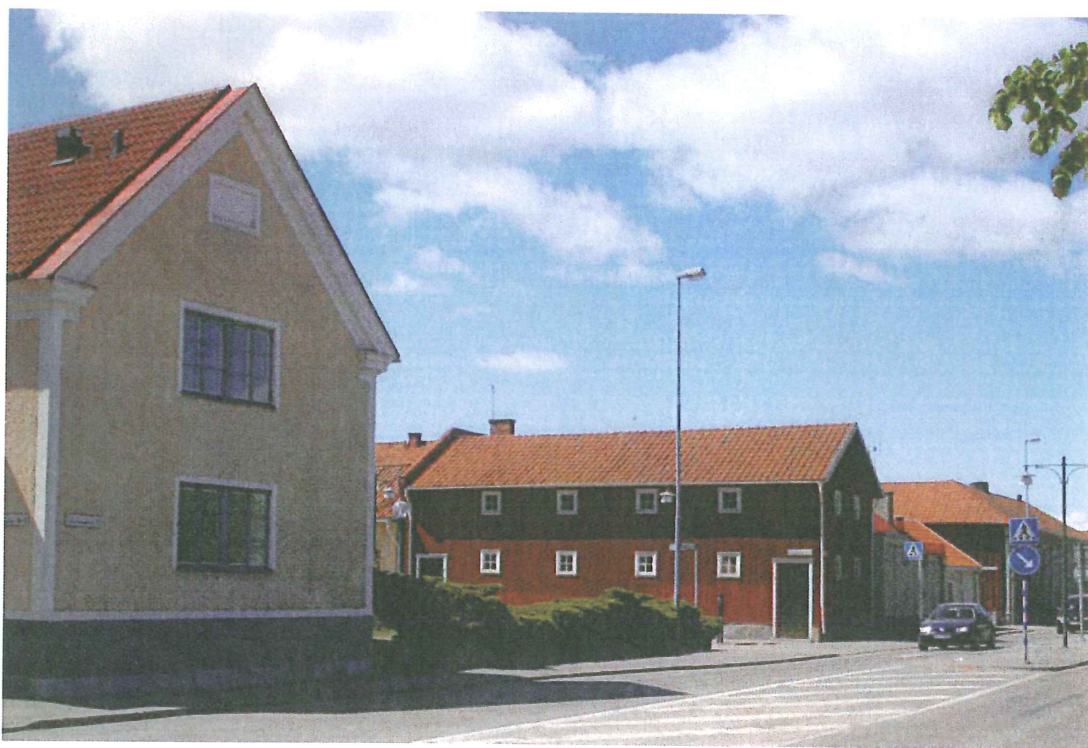
Kv Bifrost 4 sett från Kållandsgatan före.
